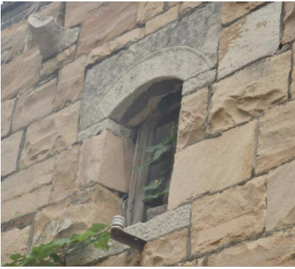
图5 济宁 - 武翟山村: 该窗过梁采用三道宽 12 厘米左右的料石拼帮而成, 从正立面看, 显得非常大气。过梁上做出了弧状纹样。
