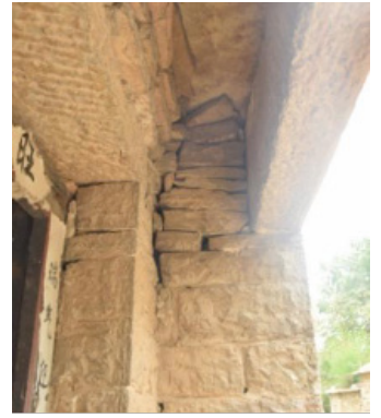
图7 泰安 - 朝阳庄: 该门过梁外部有一块独立的骑门石, 内部又有独立的门过梁。
