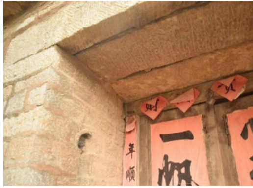
图6 泰安 - 尹山庄: 该门过梁采用三道不同宽度的料石拼帮而成。石材上方雕刻了直线或斜线的鏊痕。
